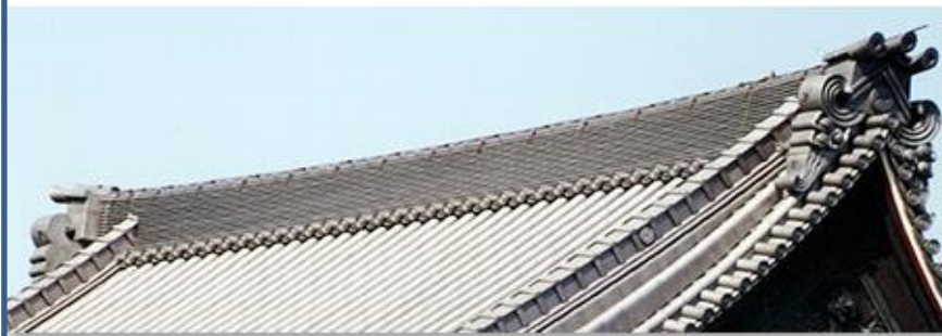
写真② 熨斗瓦で積み上げている(裏面)
