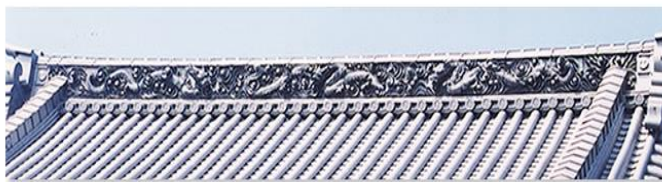
写真① 水板瓦の納まり(表面)
