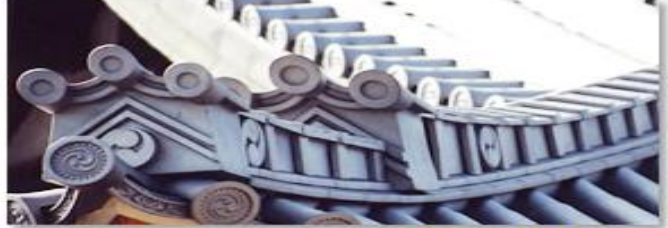
写真◎ 降り棟の箱冠瓦
